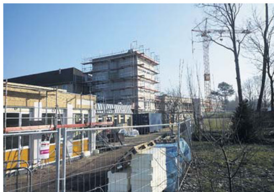
Der Anbau der Psychiatrie geht seiner Vollendung entgegen. Voraussichtlich wird das Gebäude im Herbst dieses Jahres eröffnet. Fotos privat
